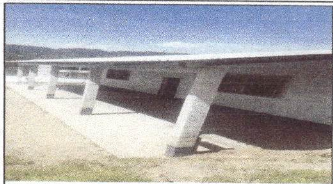
Foto 2 Capotes instalados al cien por ciento
