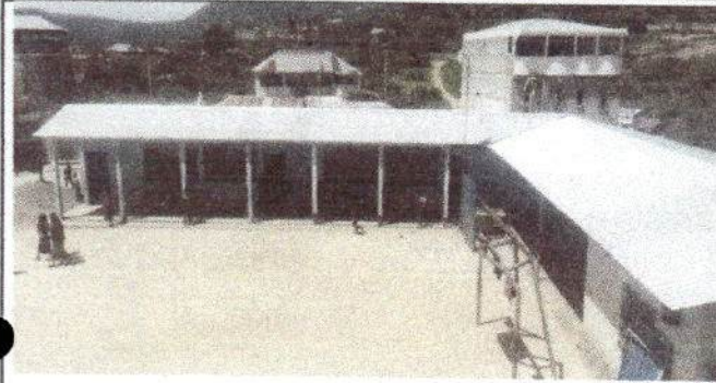
Foto 1: Lámina instalada al cien por ciento
