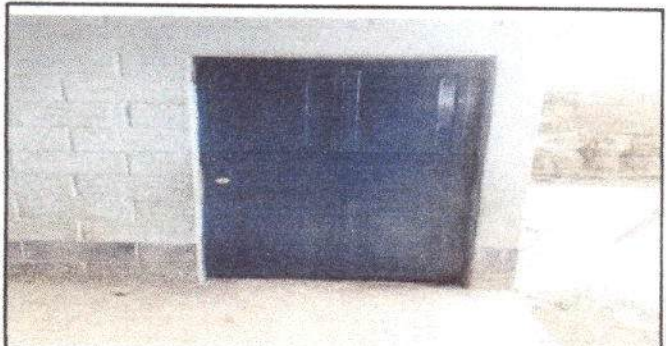
Foto 6: Puerta instalada al cien por ciento
