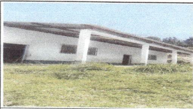
Foto 3: Elementos de fijación instalados al cien por ciento
